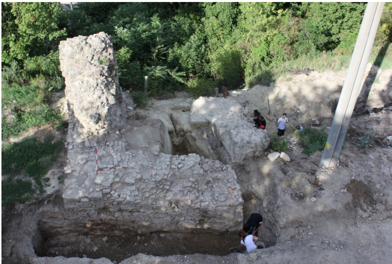
obr.03 Pohľad na odkrývanie rožnej veže v severozápadnom nároží hradu
